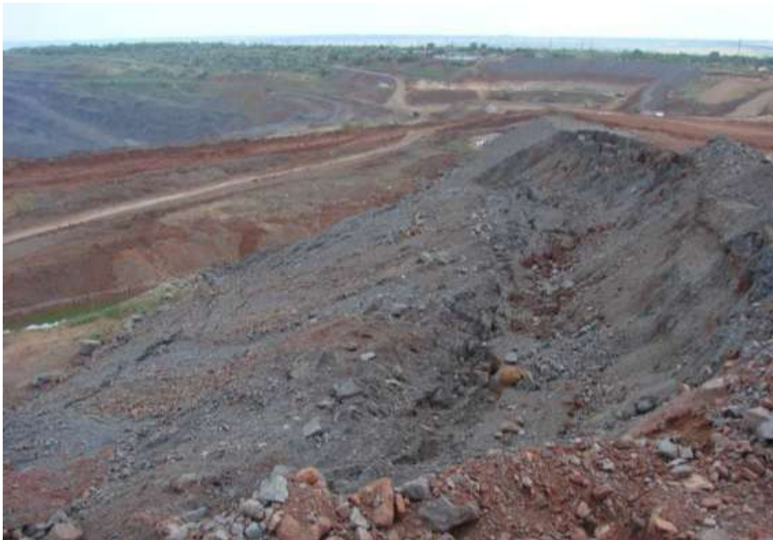
Рисунок 1 - Оползень насыпи конвейерного тракта
